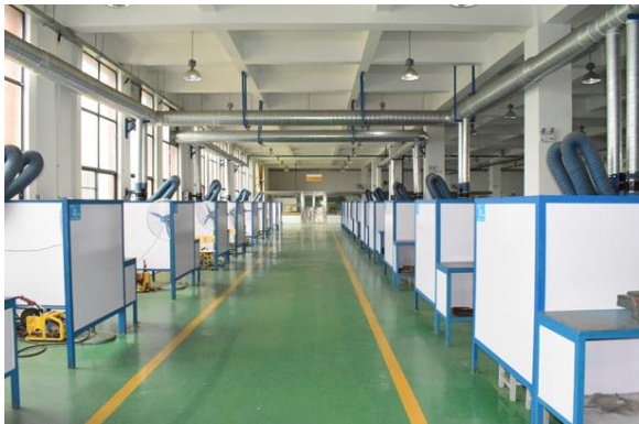
图 16 焊接加工实训室
